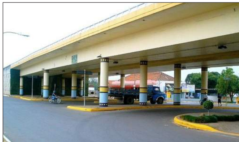
Viaduto Alfredo Lemmertz
